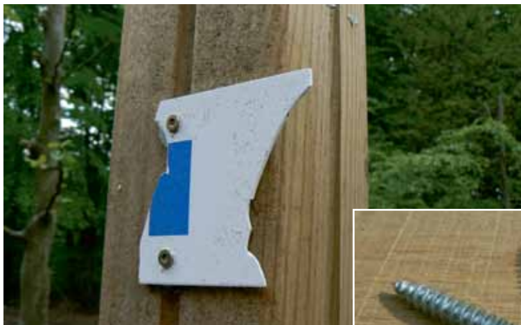
Dit dunne plastic bordje dat over de paal heen stak en met slechts twee schroeven is vastgezet breekt eenvoudig af.
